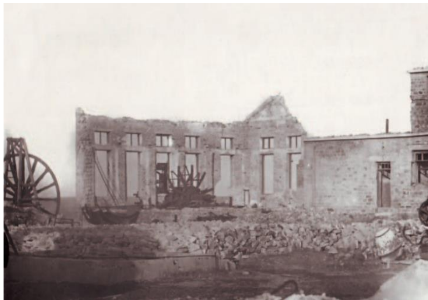
Зруйновані будівлі шахти 4-2-біс. Кадіївка. 1943 рік
